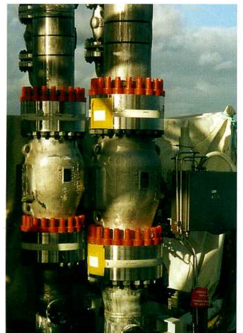
Проходные дроссельные клапаны 10" ANSI 1500 на месте добычи, FPSO, Норвегия
